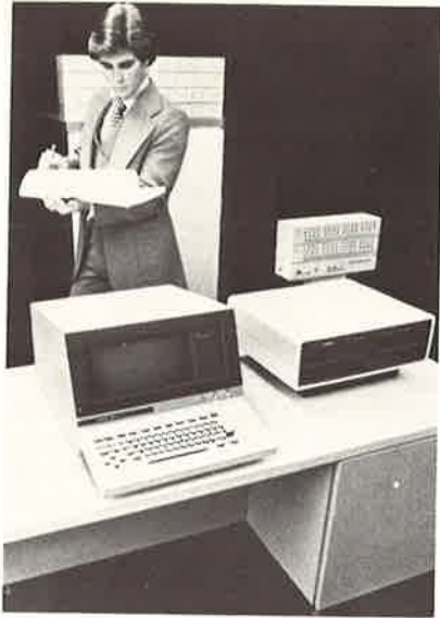
Abb. 3.3.3.2/3: Datenübertragungsrechner (Arbeitsspeicher 32 – 128 KB)
