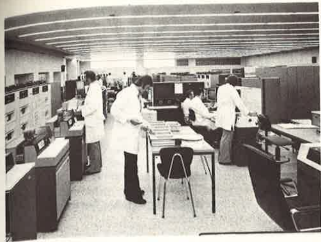
Abb. 1.2.3/3: Rechnerraum der DATEV eG mit 2 installierten Zentraleinheiten der Groß-EDV, 9 Platteneinheiten und 32 Magnetbandeinheiten
